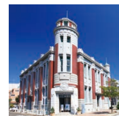
▲旧古河鉱業若松ビル
