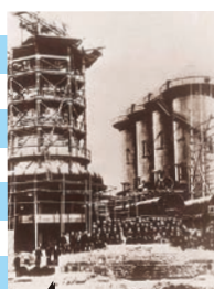
建設中の官営八幡製鐵所東田溶鉱炉
