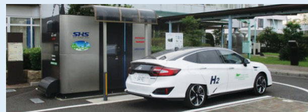
▲スマート水素ステーション
